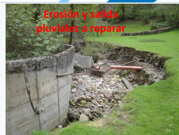
Margen izquierda proteger muro Krainer
