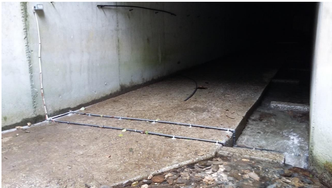
Foto 10: antena pass-over instalada en el túnel de Iruribieta en estiaje
