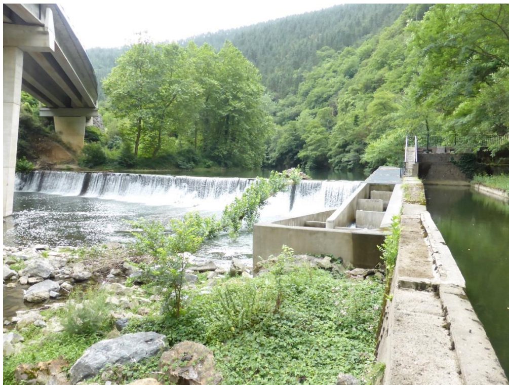
Foto 2: Azud y dispositivo de paso para peces de la Central de Murgues
