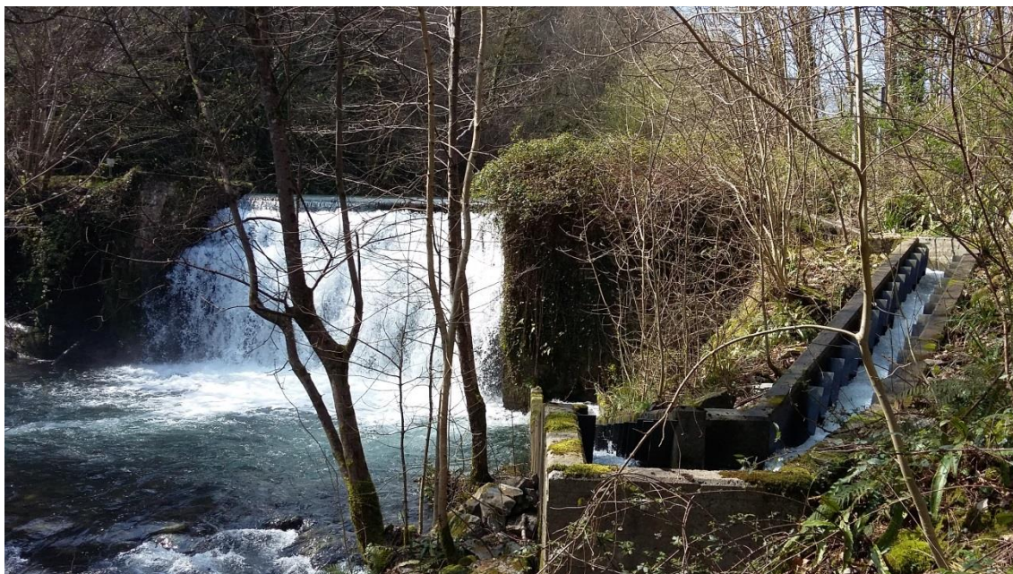
Foto 4: azud y dispositivo de paso para peces de la Central Yanci II
