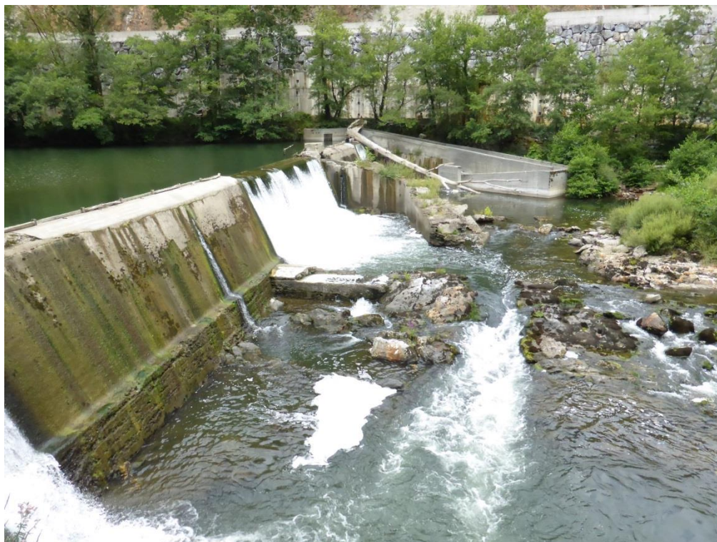
Foto 1: Azud y dispositivo de paso para peces de la Central de Nabasturen
