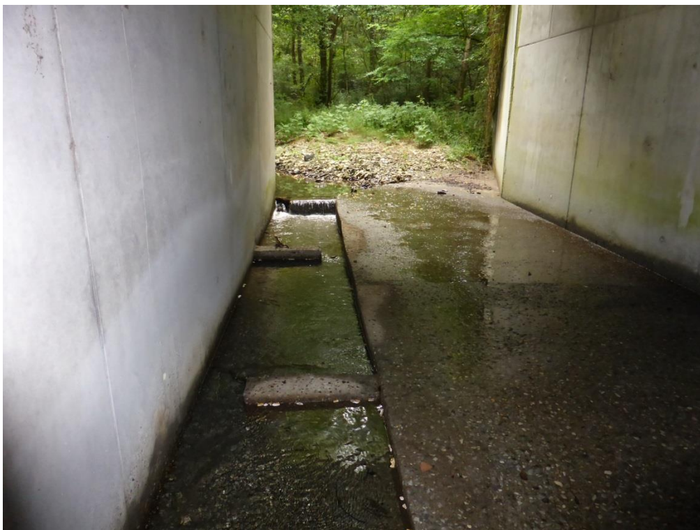
Foto 3: Marco de hormigón y dispositivo de paso para peces en la regata Iruribieta durante el estiaje
