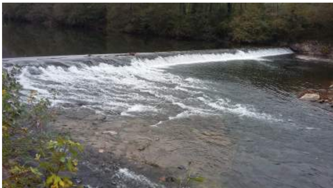
Foto 9: Azud y rampa de paso para peces del Molino de Jorajuria en el río Bidasoa
