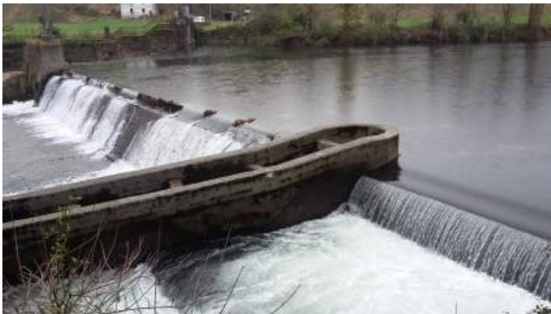
Foto 7: Azud, escala para peces (centro) y rampa de antediques (derecha) de la Central de Yanci I en el río Bidasoa
