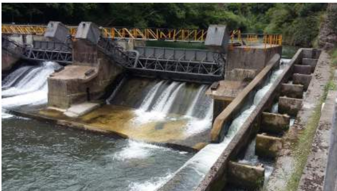
Foto 10: Azud y escala para peces de la Central de San Tiburcio en el río Bidasoa
