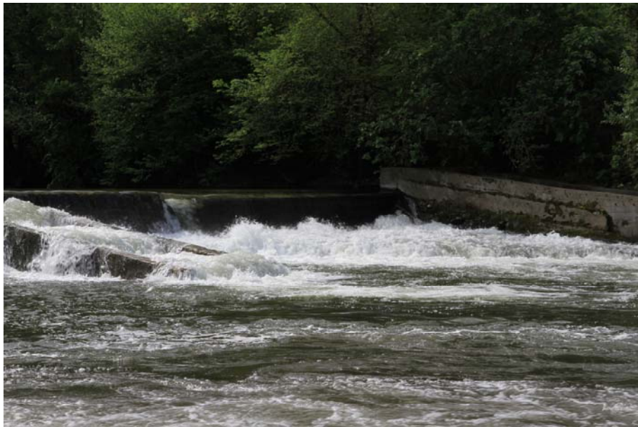
Aspecto coronación presa con escotadura y escala en margen izquierda presa
