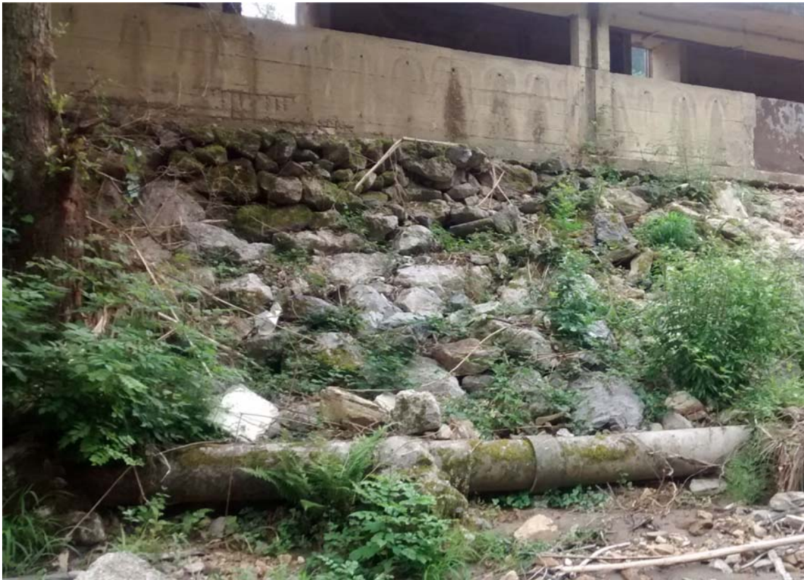
Vista desde el cauce. Muros y Canales a demoler. Tubería de fibrocemento.
