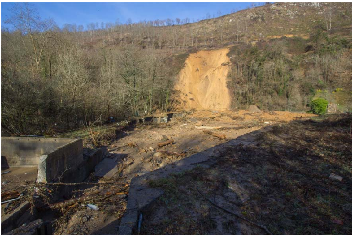
Vista desde el extremo Aguas Arriba. Desprendimiento del talud en la margen izquierda.
