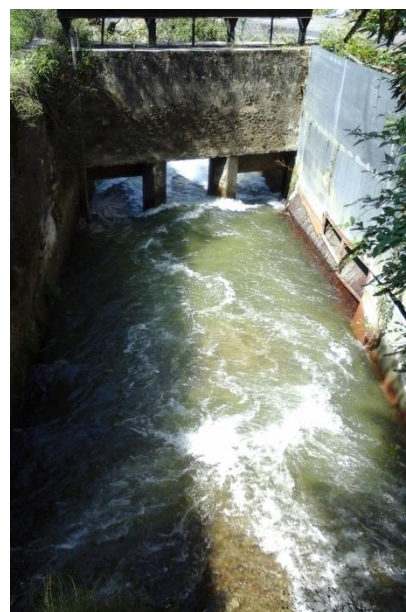
Apertura compuertas de la toma de la central para rebajar la lámina de agua de la zona embalsada
