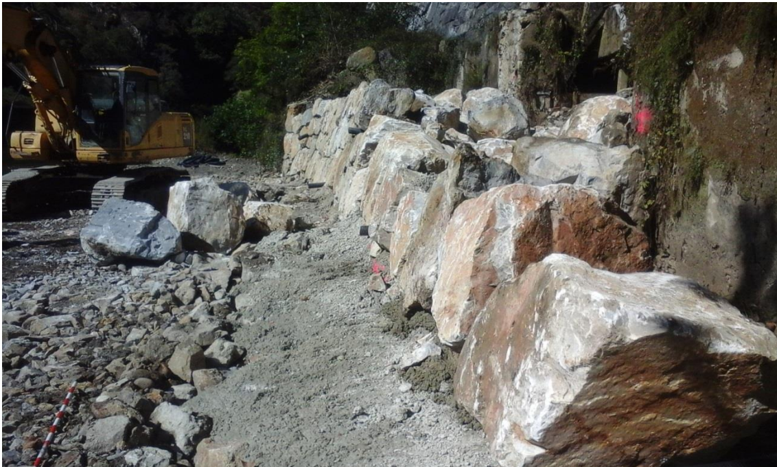
Proceso de alzado del muro. Acondicionamiento hidrodinámico en la margen derecha
