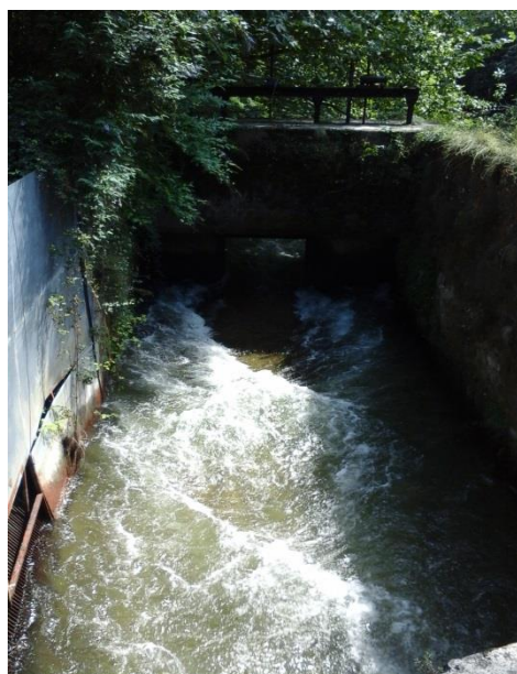
Apertura compuertas de la toma de la central para rebajar la lámina de agua de la zona embalsada
