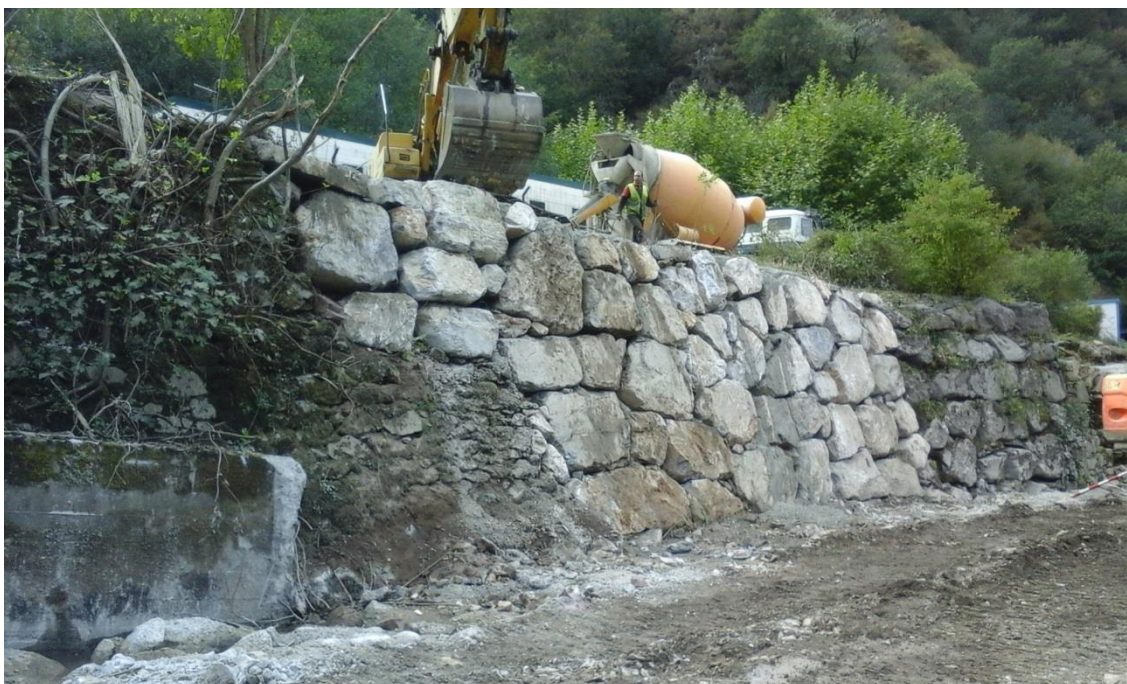
Aspecto del alzado en los tramos deteriorados de las protecciones existentes en margen izquierda
