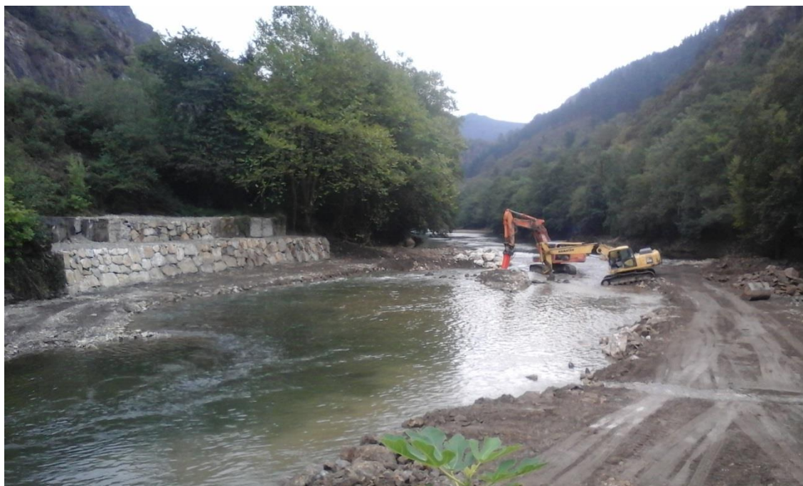
Demolición de la parte inferior de la presa conforme avanzan los trabajos en la margen izquierda
