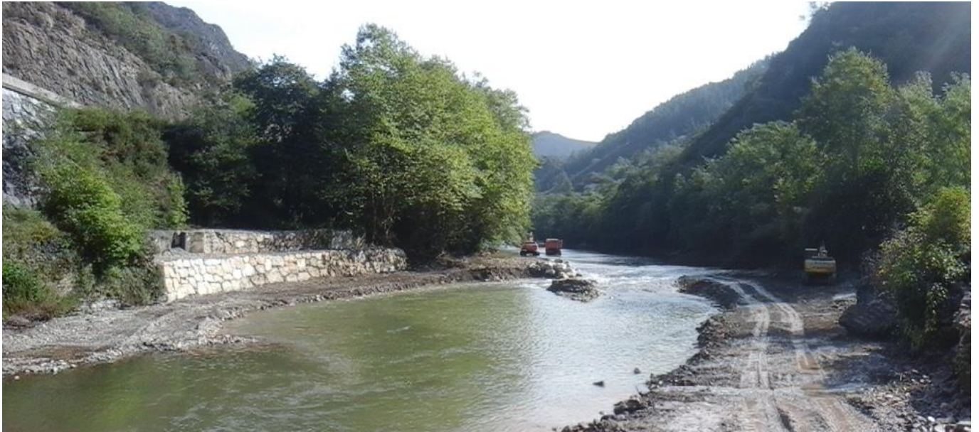
Aspecto del cauce con la ataguía en la margen izquierda
