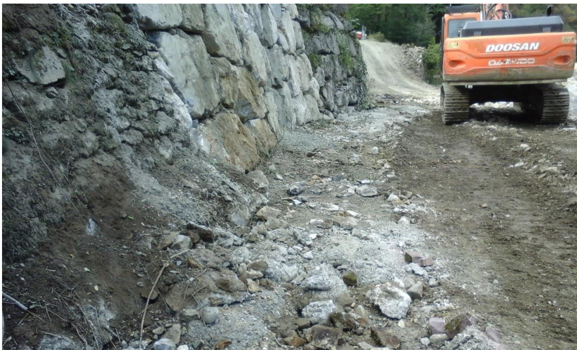
Aspecto del refuerzo de la base, protecciones existentes y alzado de los tramos deteriorados en la margen izquierda
