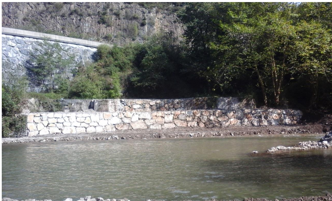
Aspecto del acondicionamiento hidrodinámico realizado en la margen derecha
