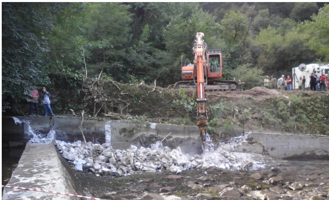
Margen izquierda desbrozada e inicio de la demolición de la escala de peces
