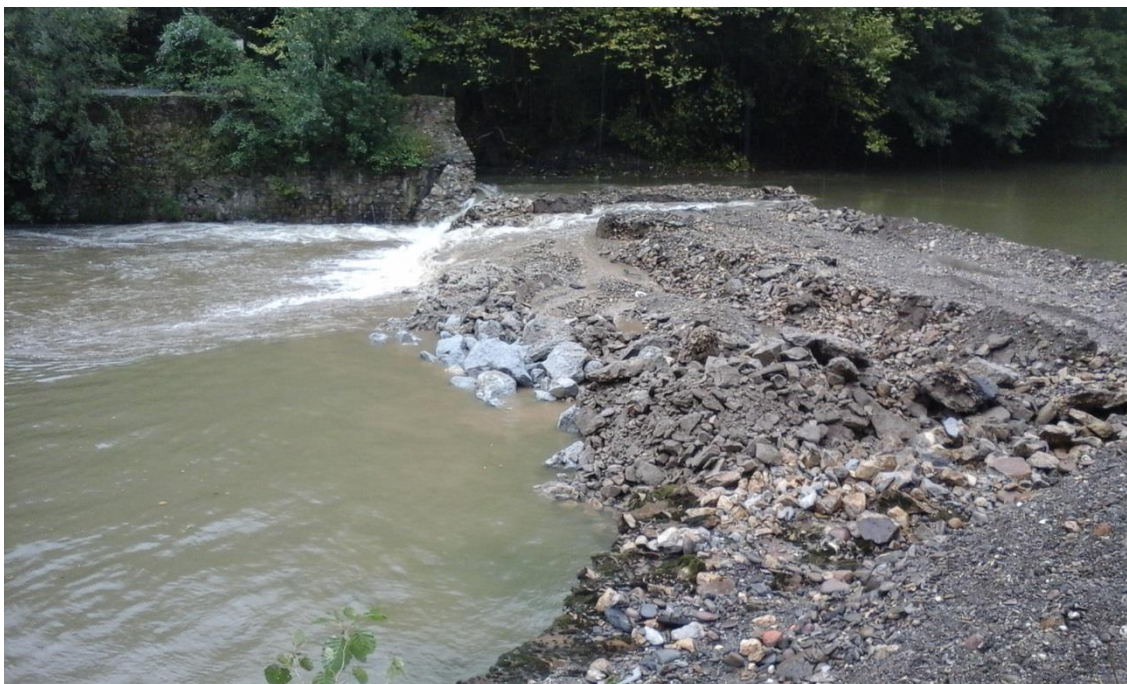
Ataguías para desviar el flujo del agua
