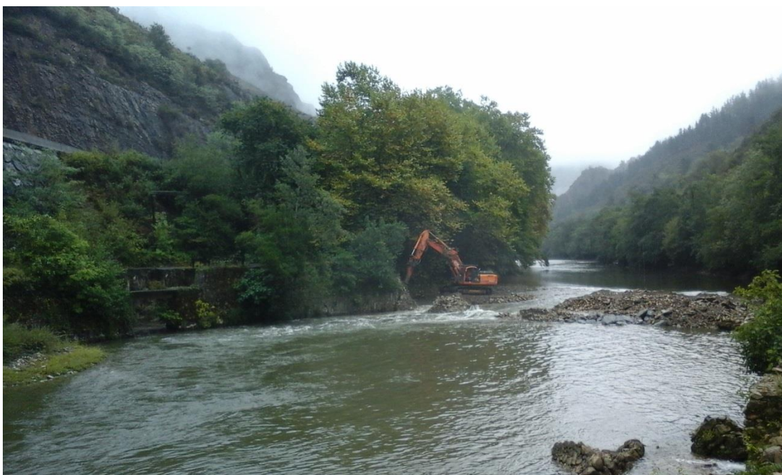
Inicio de la demolición de la toma de agua en la margen derecha
