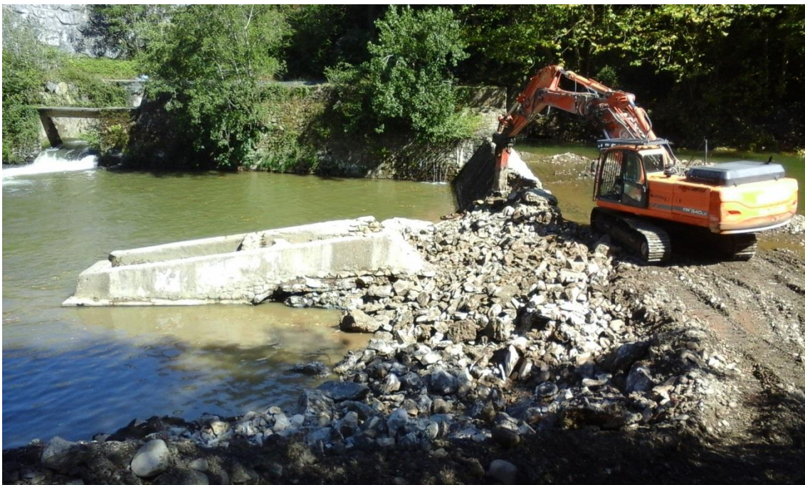
Proceso de demolición de la presa
