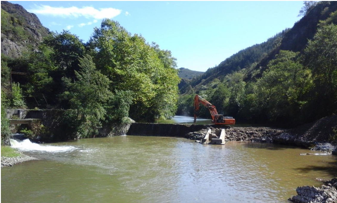
Inicio de la demolición del azud desde la margen izquierda (desde la ubicación del acceso)
