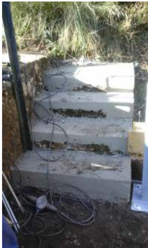
Acondicionamiento escaleras de acceso al canal
