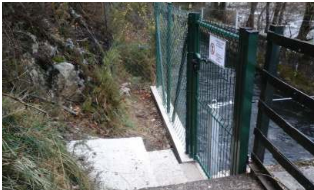
Aspecto escaleras, valla y puerta de acceso al canal
