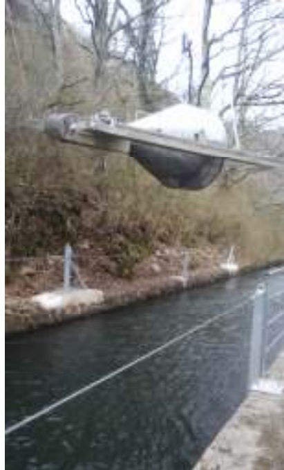
Proceso instalación "Sistema RST" en el canal
