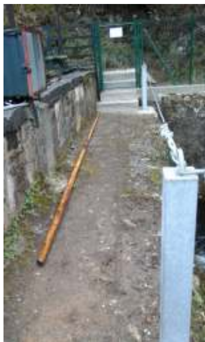
Detalle acceso con paso sobre canal
