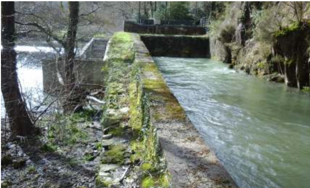
Toma de agua del canal
