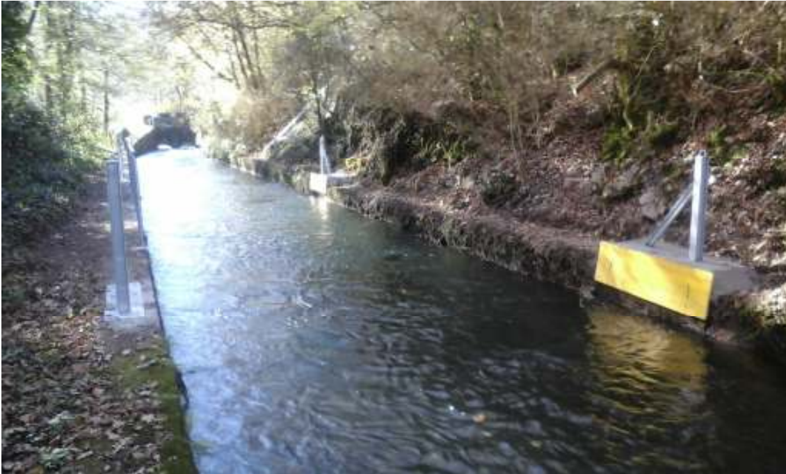
Instalación soportes anclaje “Sistema RST”
