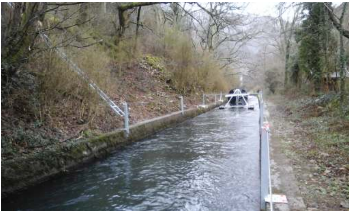
Imagen canal con vista del “Sistema RST” colocado y líneas de anclaje horizontal en ambas márgenes, con sendero paralelo a las líneas de anclaje horizontal, observándose así mismo la escalera de acceso a la margen izquierda del canal
