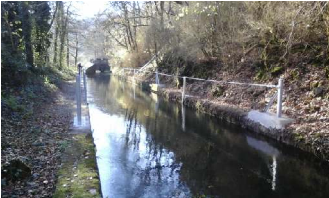
Instalación línea anclaje horizontal en margen izquierda del canal
