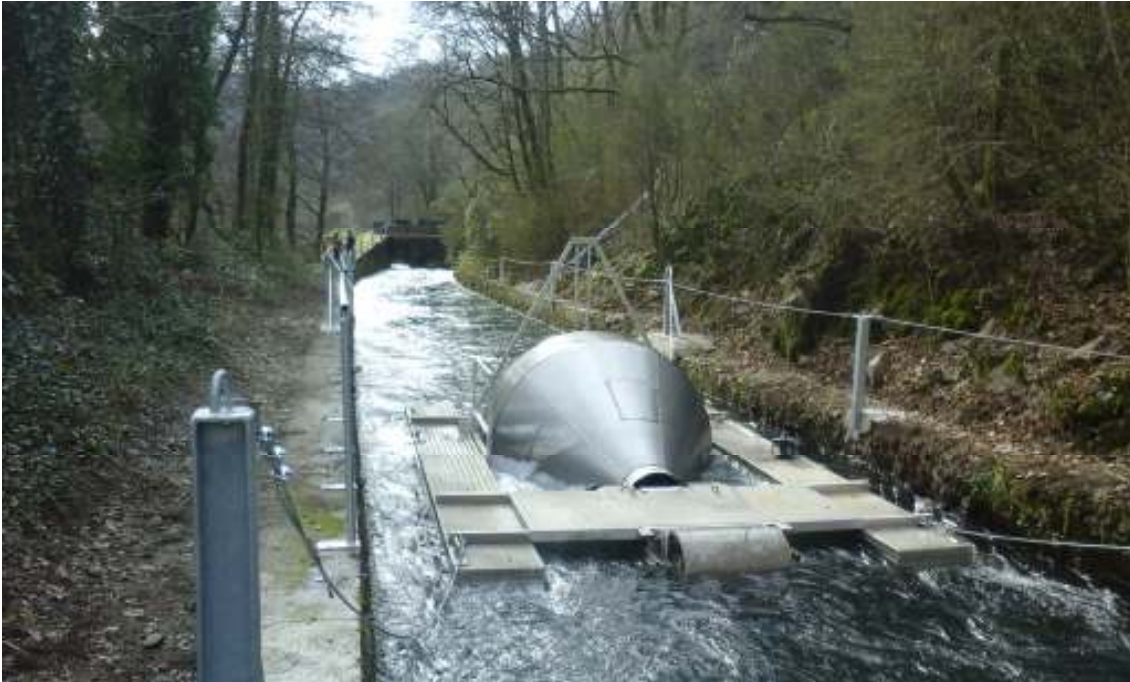
Imagen aspecto canal, “Sistema RST”, barandillas, senderos, líneas horizontales de anclaje, visto desde aguas abajo
