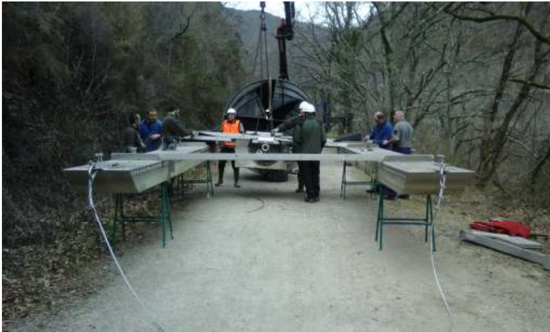
Proceso de montaje del “Sistema RST”
