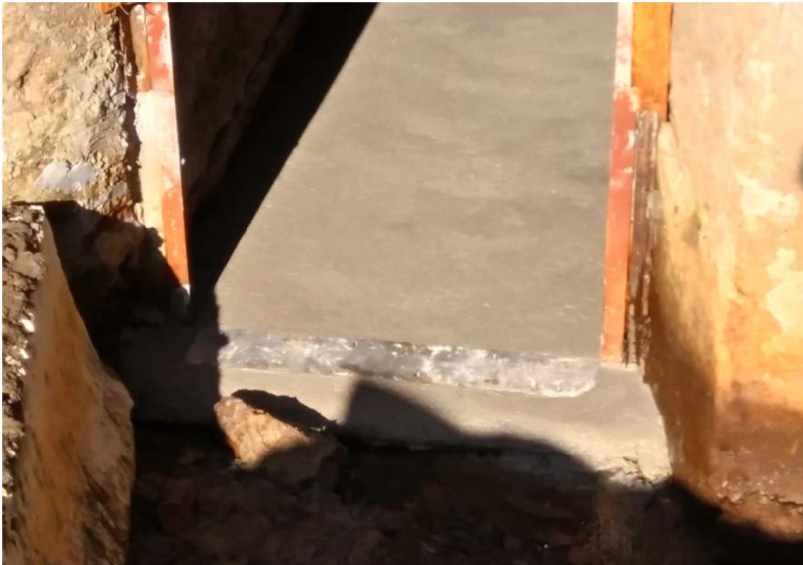
Chapa de acero para asiento de compuerta.
