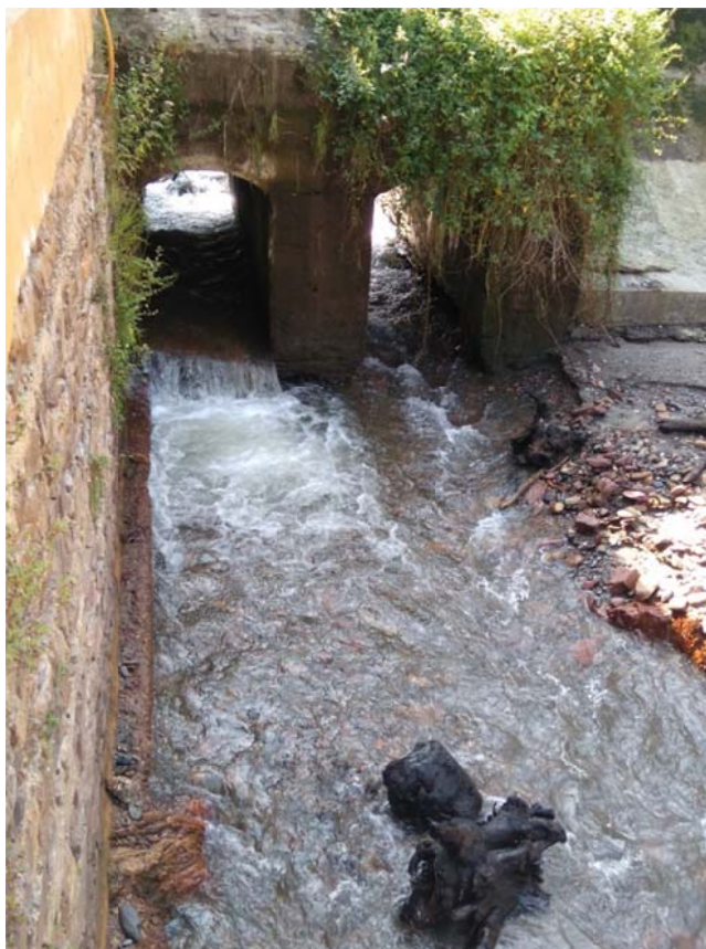
Estado del Desagüe de Fondo Aguas Abajo
