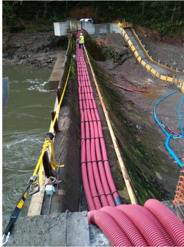
Los conductos preparados para el hormigonado
