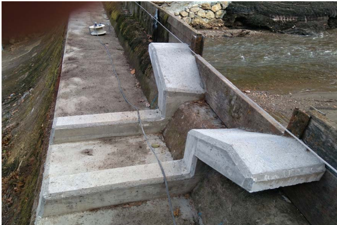
Estado final hormigonado. Escotadura alineada con la entrada a la esclusa.
