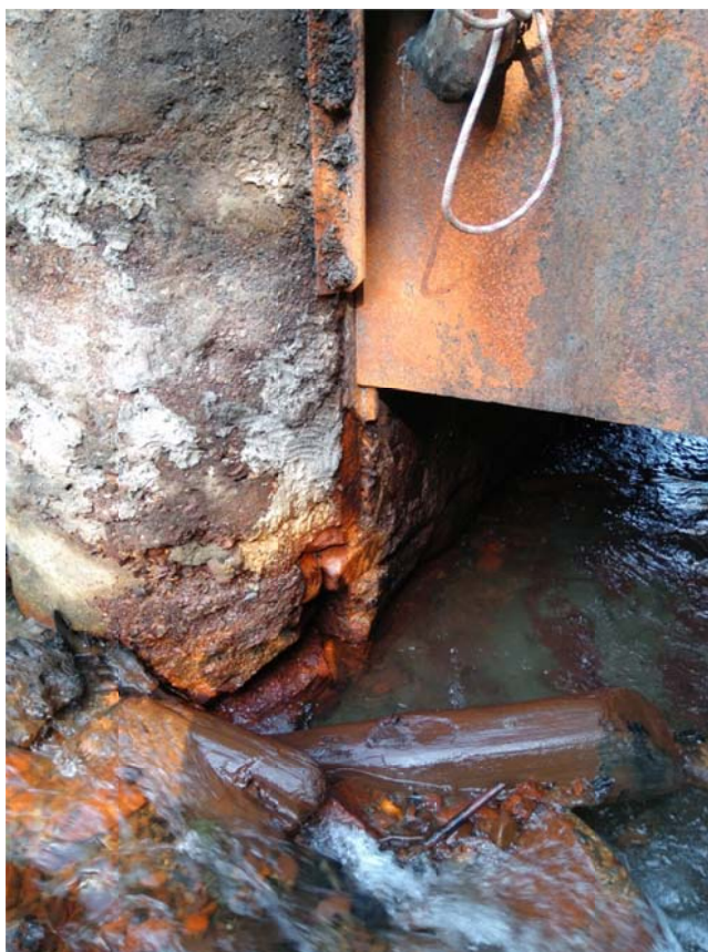
Estado del desagüe de Fondo Aguas Arriba
