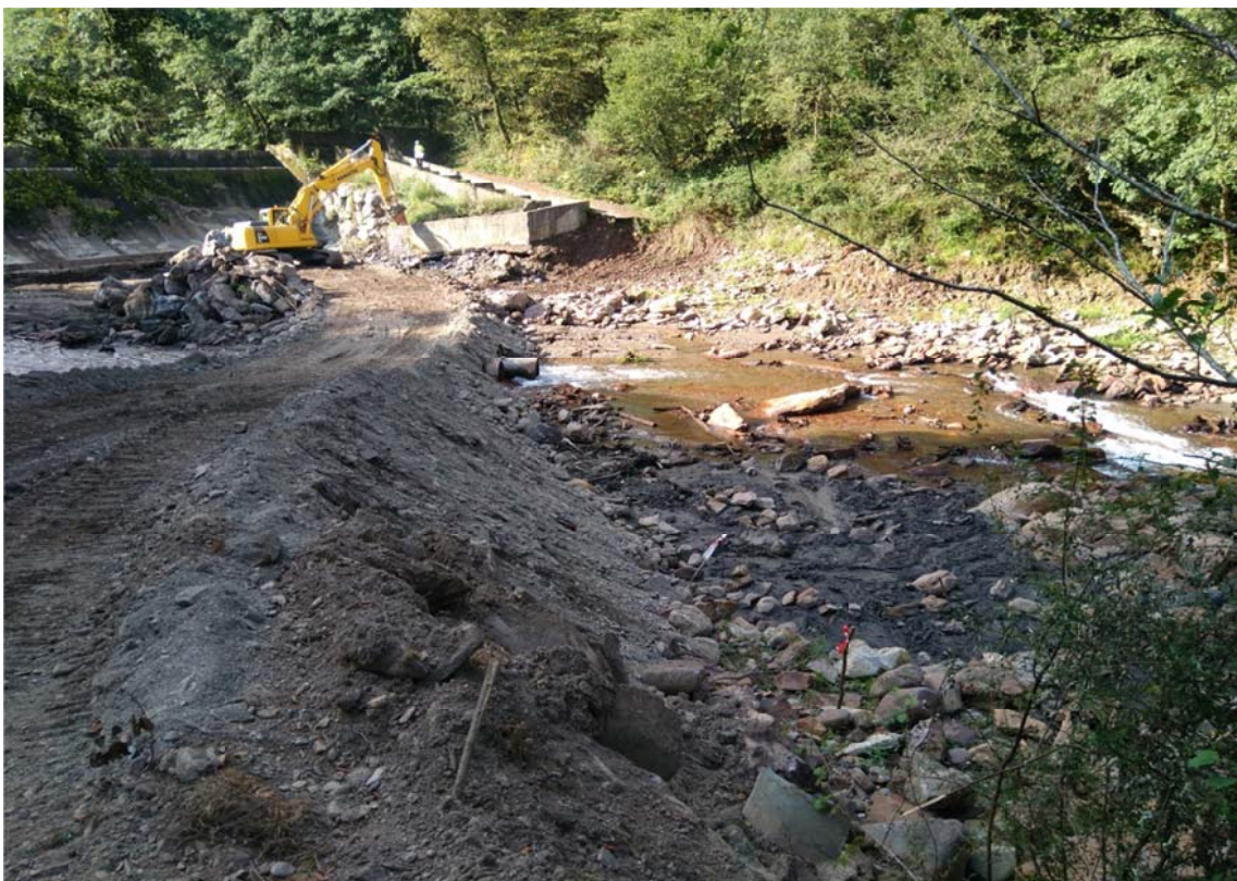
Retroexcavadora demoliendo la escala de peces.
