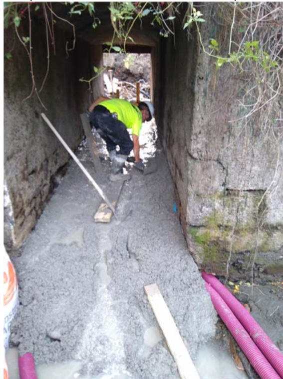
Hormigonado de solera del canal de desagüe
