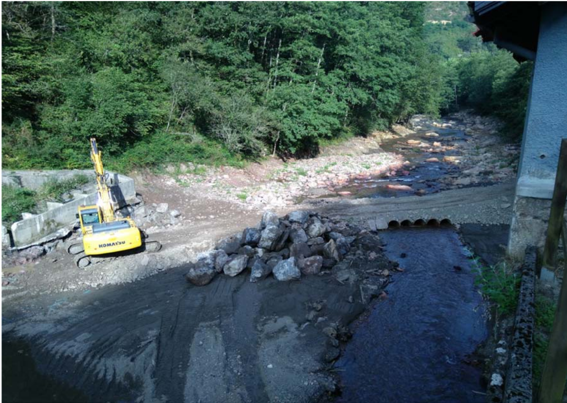
Ataguía y acopio de escollera desmontada.
