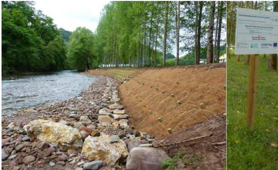
Figura 2. Tramo piloto en la cuenca del Bidasoa en Navarra en que se ha aplicado distintas técnicas de bioingenierías para afrontar problemas de erosión y contribuir a la restauración del río.
