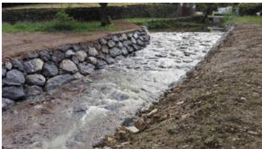
Foto final de la rampa de peces ejecutada.
