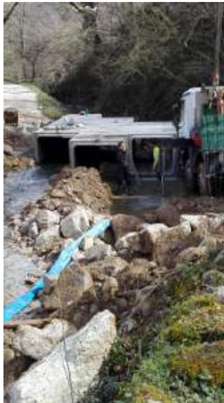
Colocación de cajones prefabricados.
