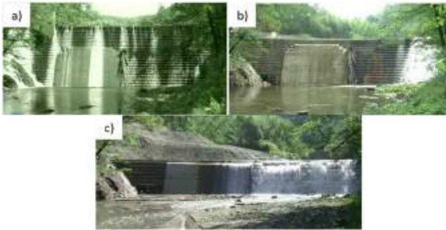
Figura 1: Imágenes de la presa de Inturia a) antes del comienzo de la demolición, b) después de la primera fase de demolición (agosto 2013) y c) tras la segunda fase de demolición (agosto 2014).
