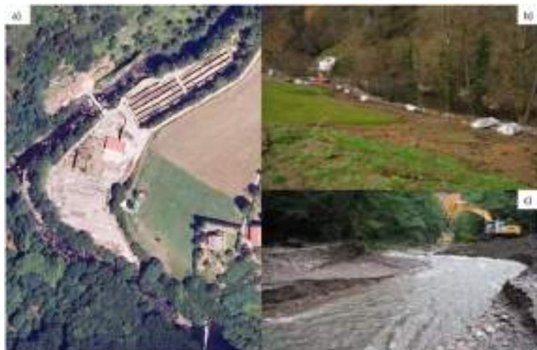
Figura 3: Imágenes de la zona de Truchas-erreka a) vista aérea de la zona de actuación, b) estado final de la margen derecha y c) trabajos de demolición de la presa de Truchas-erreka.
