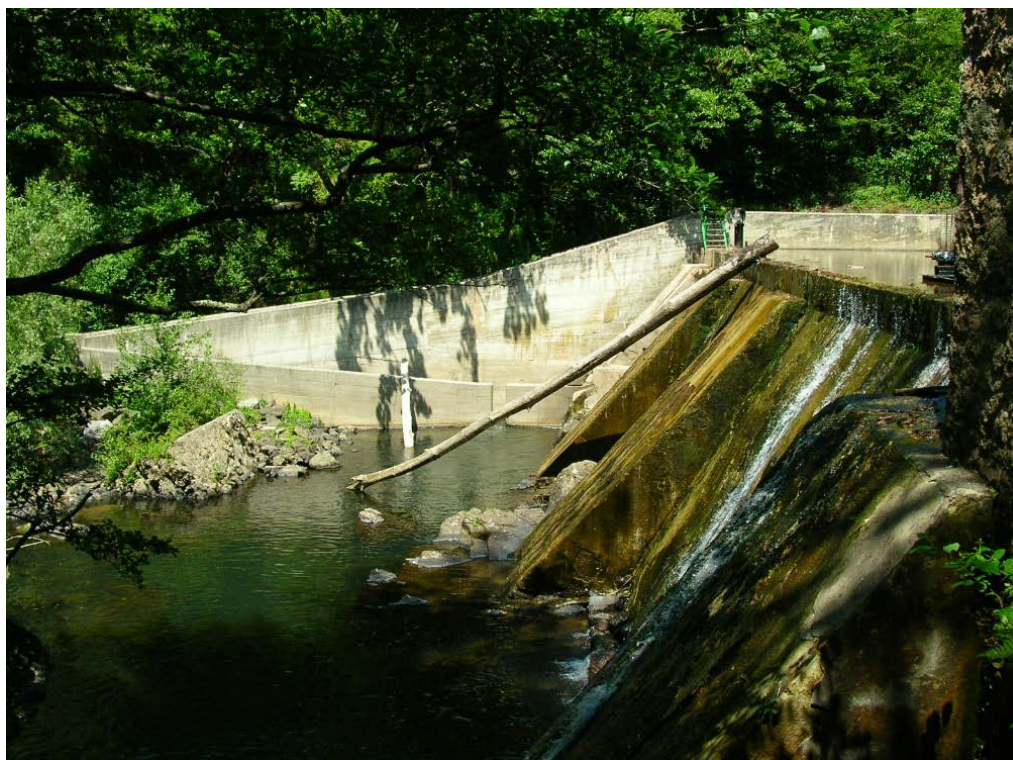
Figura 1. Azud de la C.H. Bertxin y dispositivo de paso para peces (escala de artesas sucesivas) en margen derecha.
