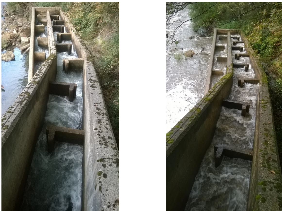
Figura 6. Artesas de la parte media de la escala con mayor y menor caudal y régimen turbulento.
